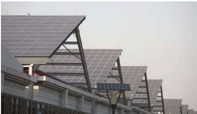
新的发酵催化技术，利用生物量资源生产出各种各样的化学制品。另外，他们还在通过高效物流抑制CO<sub>2</sub>排放量和燃料使用量的同时，对设施本身也追求环保。以中转站为例，其主要设施第一第二国际货物大楼的大部分屋顶，设置了映照太阳光的太阳能电池模块。设备面积大约28000平方米，发电容量约2000KW的太阳能发电系统，供应整个中转站所使用的约一成电力。
